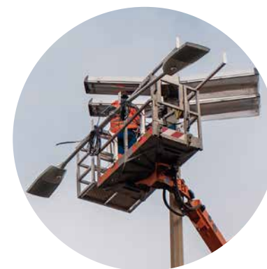
Installatie van de LED-lamparmaturen.
